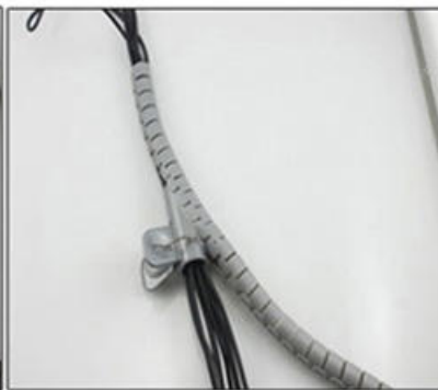
5.上移包線管或下移引線器
